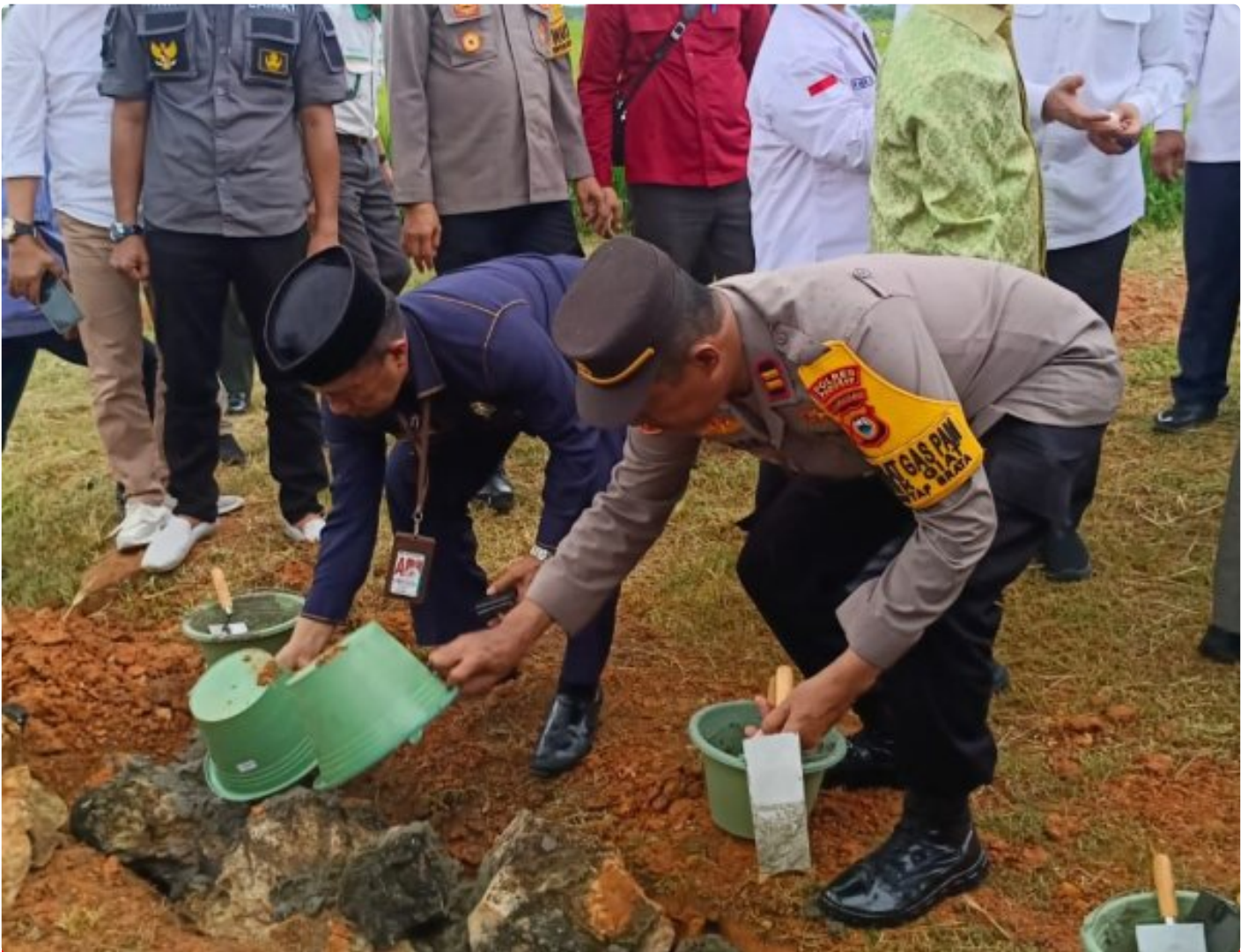
Kapolsek Minasatene Pimpin Langsung PAM Peletakan Batu Pertama Pembangunan Baznas Institute Bontolangkasa
